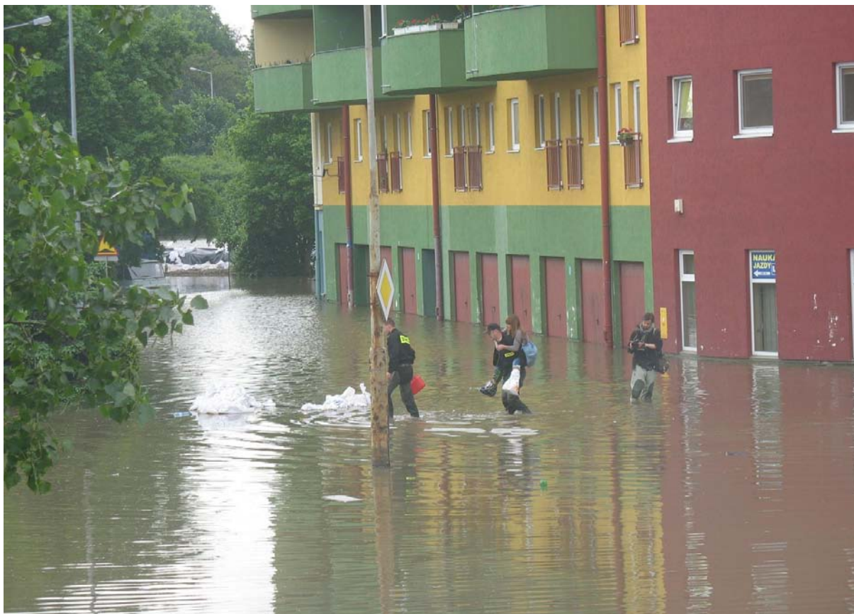
Zdjęcie nr 4 Budynki zalane podczas powodzi we Wrocławiu os. Kozanów
